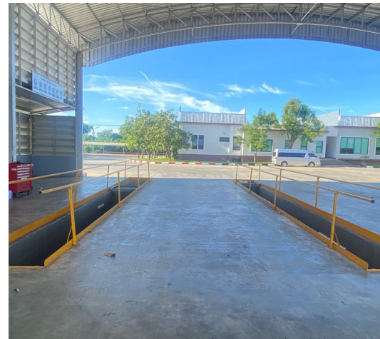
อุปกรณ์ป้องกันการพลัดตกลงหลุมตรวจรถยนต์ภายในโรงซ่อมบำรุงยานพาหนะ
