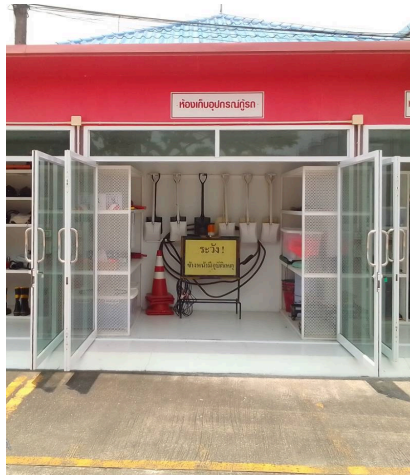
การเตรียมอุปกรณ์ระงับอัคคีภัย ณ.จุดใช้งาน
