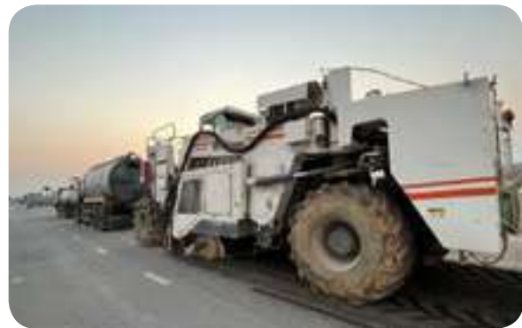
โครงการ Cold In Place Recycling โดยบริษัท ADCo - ถนนเส้น Vinh Phuc (2023) ทางหลวงหมายเลข 13 ในประเทศเวียดนาม
