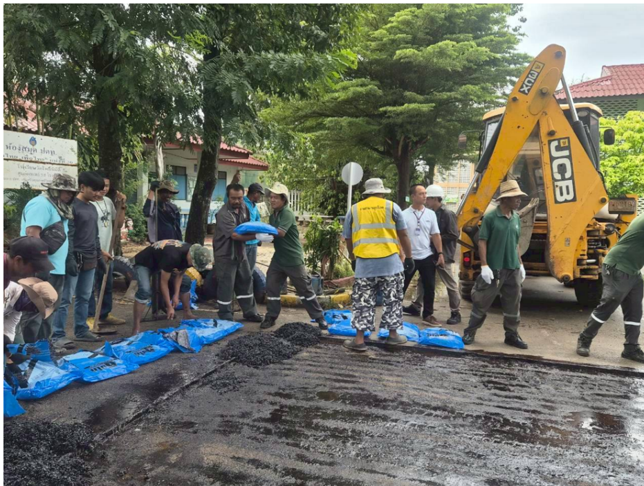
โครงการซ่อมแซมหลุมบ่อด้วยยางมะตอยผสมสำเร็จ TPCO Premix
